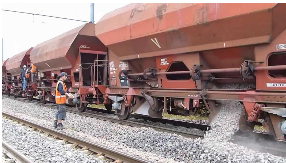
Ballastage de la voie
